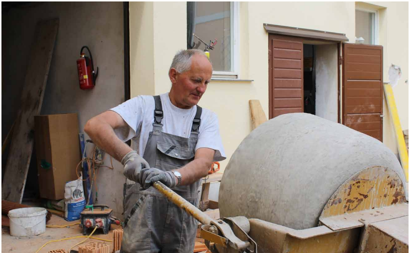
Drehscheibe und Baustellenkoordinator Alois Zehetgruber beim Betonmischen
