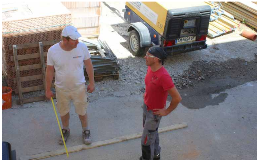
Polier Salzmann und Bauherr Haag bei der Feinabstimmung
