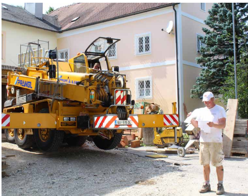
Für die Deckenverlegung musste ein Kran passgenau zwischen die beiden Gebäudeteile manövriert werden.
