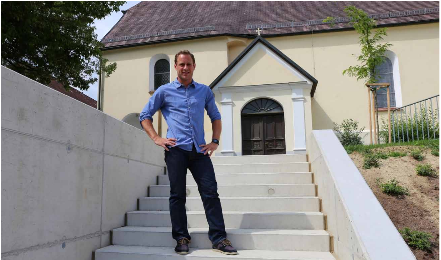
Helmut Katzengruber beim neuen Stiegenzugang zum südlichen Haupteingang der Kirche. Die Stufen sind ein Fertig-Teilelement der Fa. Lehner.
