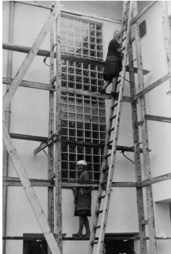
In diesem Bauabschnitt wird der Neubau von Gerüsten umrahmt – einerseits für das Verputzen der Fassade, andererseits für das Fensterputzen.
